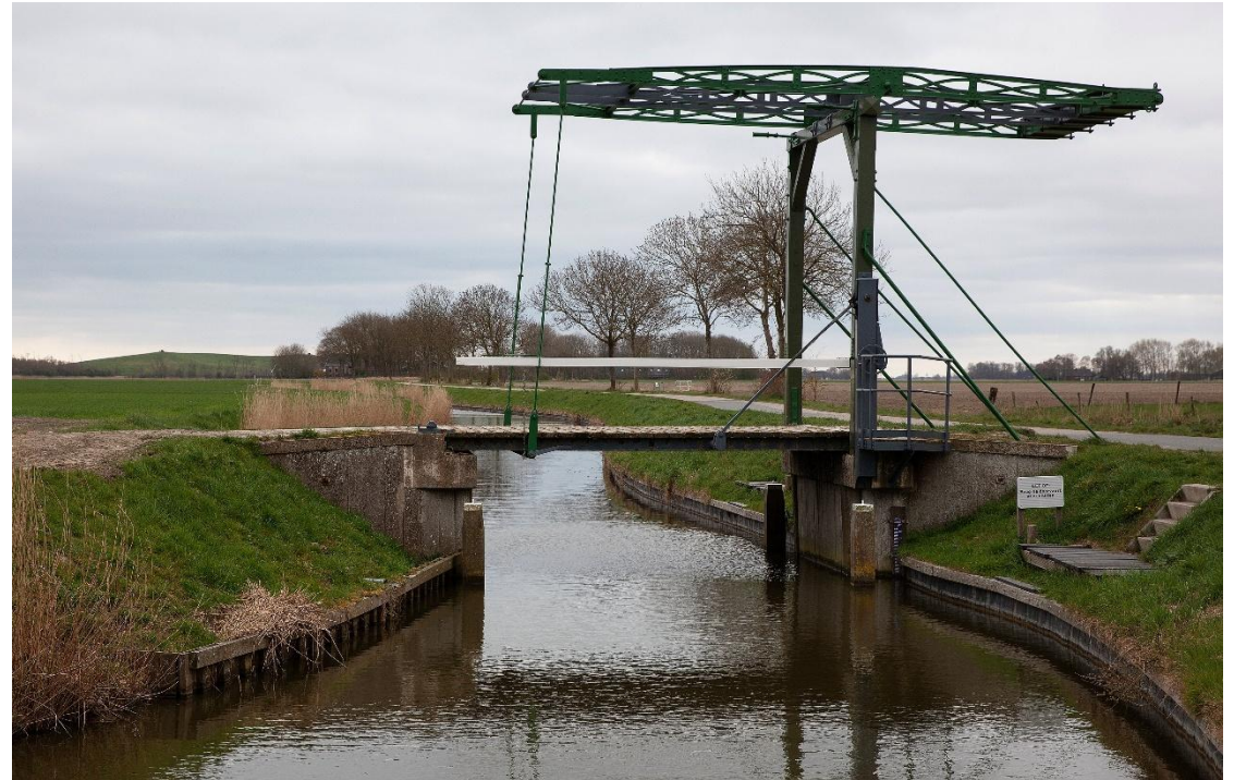
De gerestaureerde klapbrug aan de Westerhornseweg in Usquert
